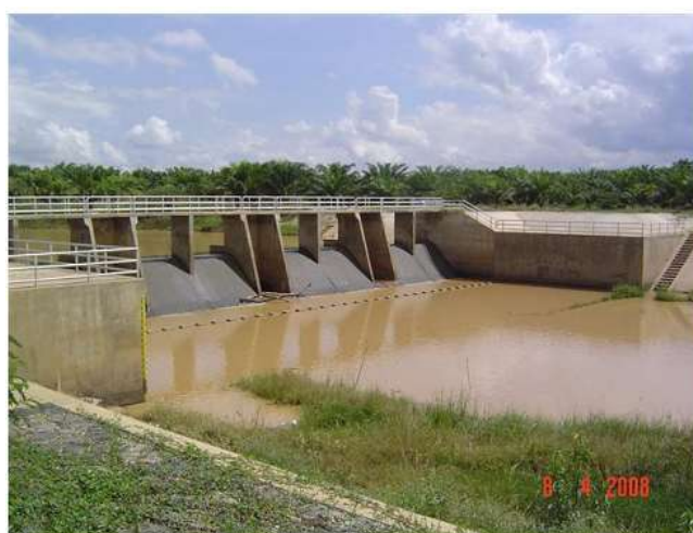
รูปภาพที่ ๕๐ ตัวอย่างฝายน้ำล้นสันมน ที่มา:สำนักงานการปฏิรูปที่ดินเพื่อเกษตรกรรม.(๒๕๖๑).
